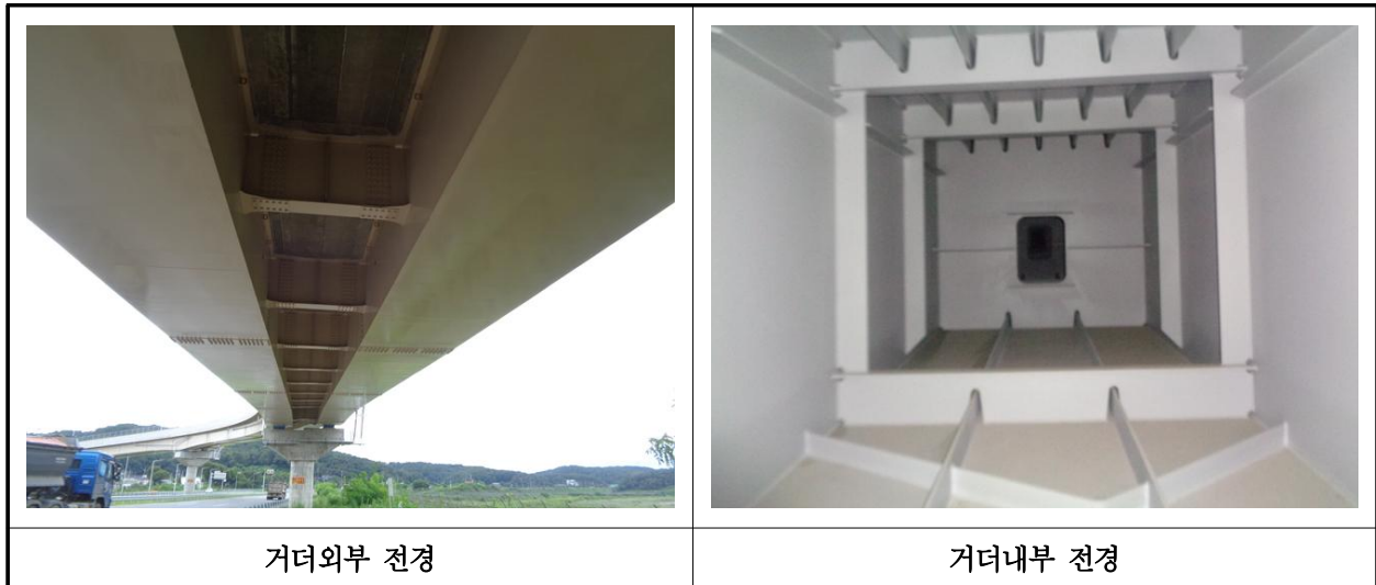
【사진 42.3.4】 거더 전경
