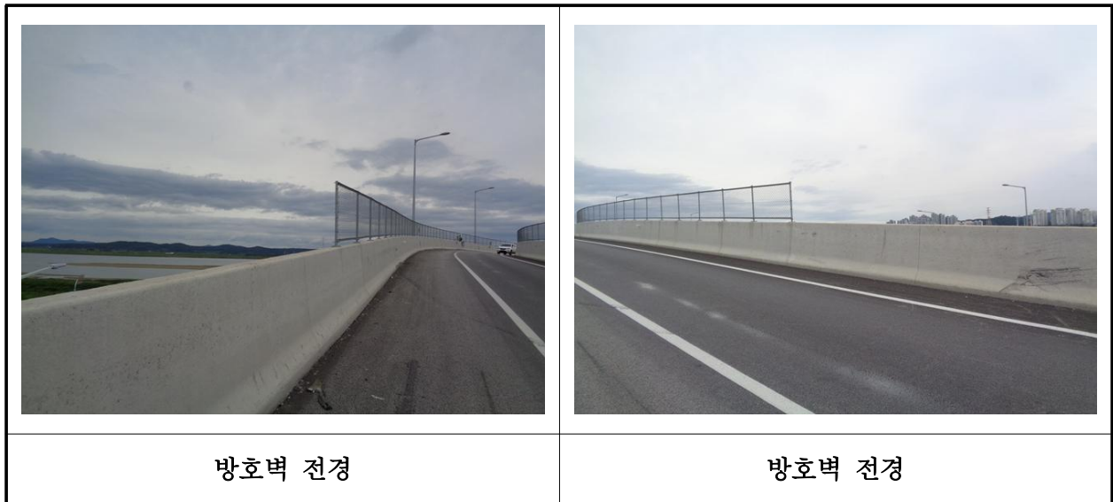
【사진 42.3.23】 방호벽 및 중앙분리대 전경
