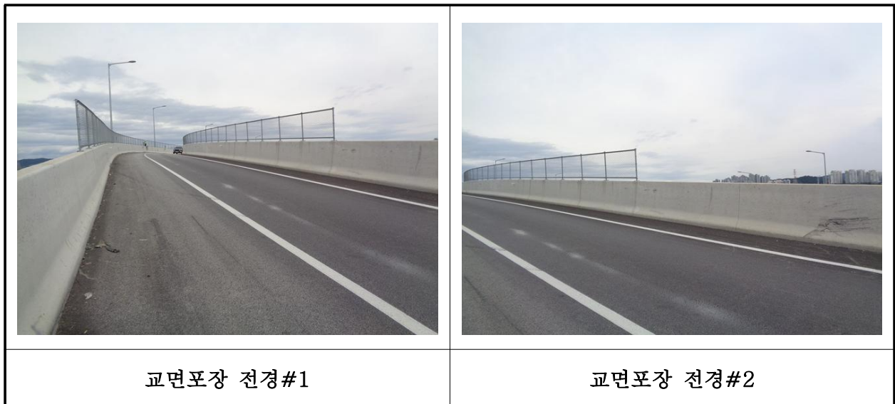
【사진 42.3.19】 교면포장 전경
