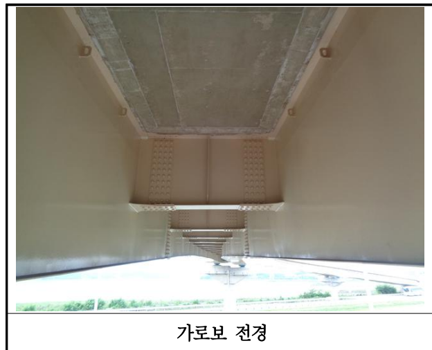
【사진 42.3.6】 가로보 전경
