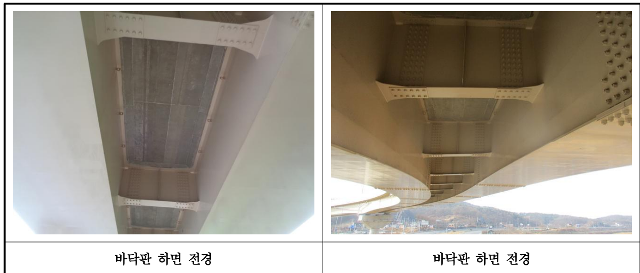
【사진 42.3.2】 바닥판하면 전경
