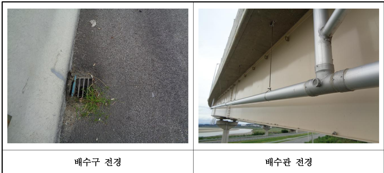
【사진 42.3.21】 배수시설 전경
