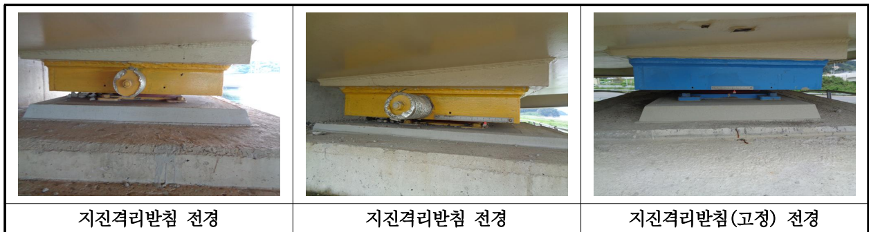
【사진 42.3.12】 교량받침 전경
