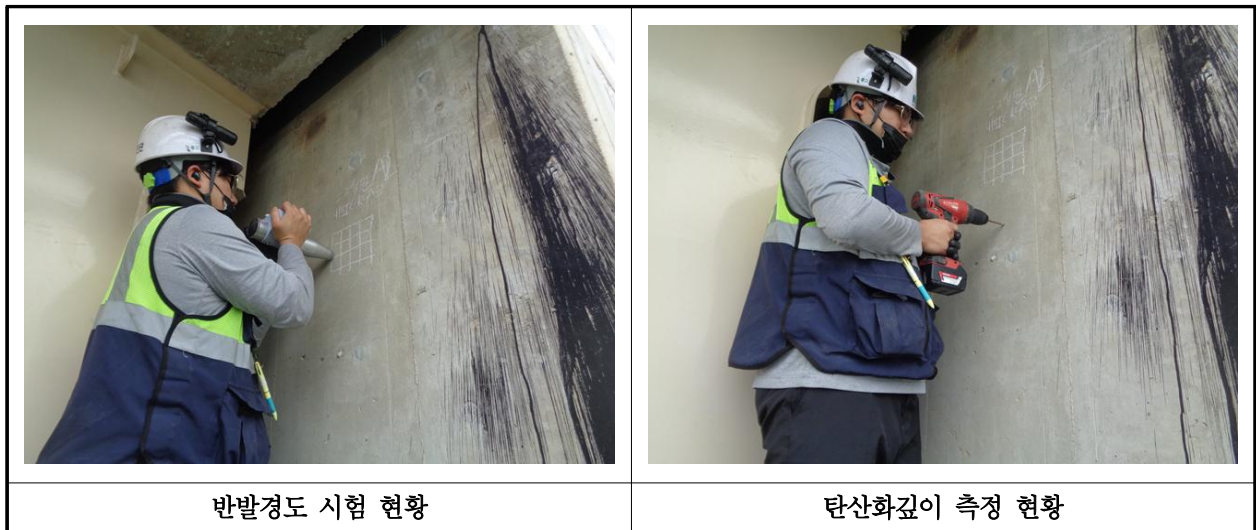
【사진 42.4.1】 콘크리트 내구성조사 현황
