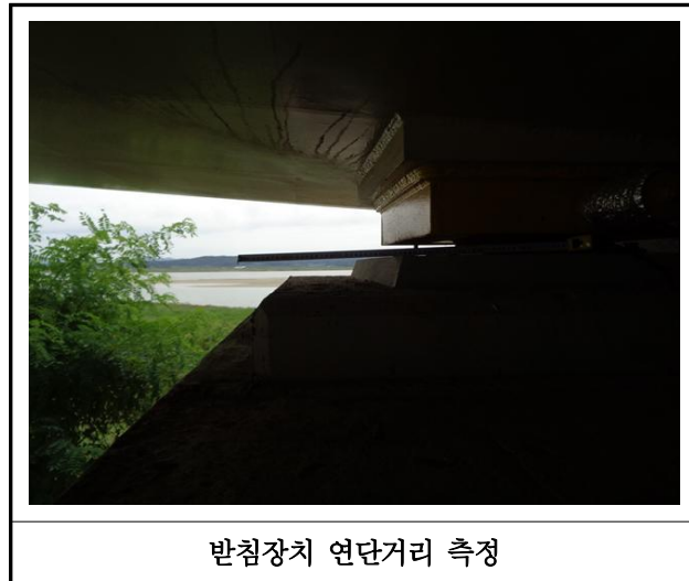
【사진 42.3.14】교량받침장치 연단거리측정
